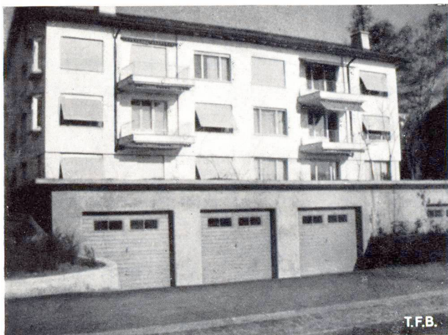
Fig. 2 Groupe de garages attenant à un immeuble locatif
