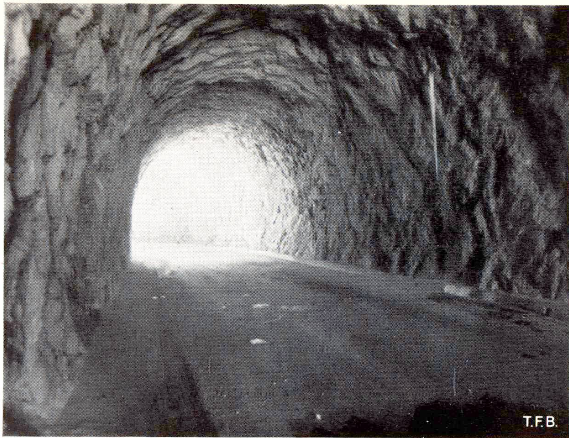
Fig. 5 Tunnel à parois rocheuses brutes avec glaçon en forme de stalactite
