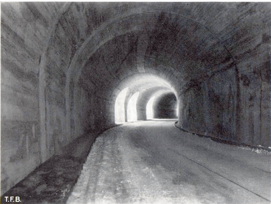
Fig. 2 Long tunnel routier bétonné présentant de bonnes conditions de visibilité
