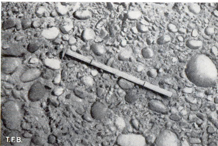
Fig. 11 Le béton après le traitement au jet de sable
