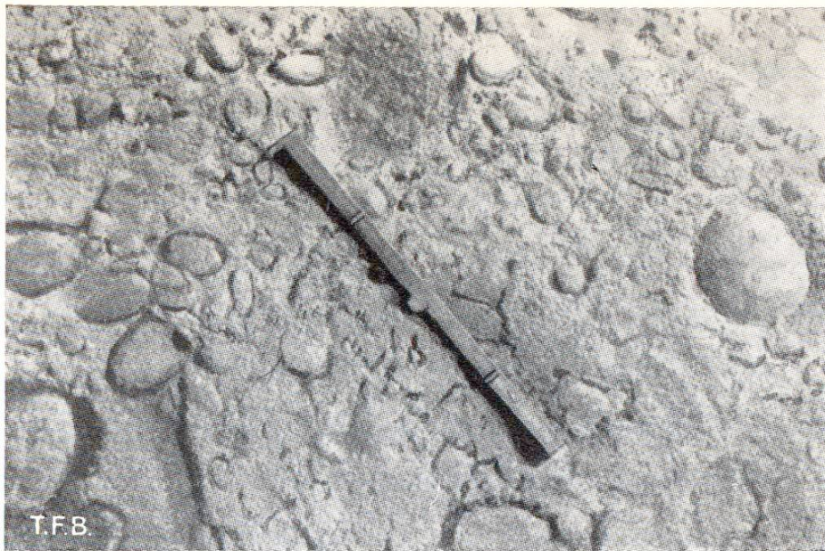
7 Fig. 10 Le béton avant le traitement au jet de sable
