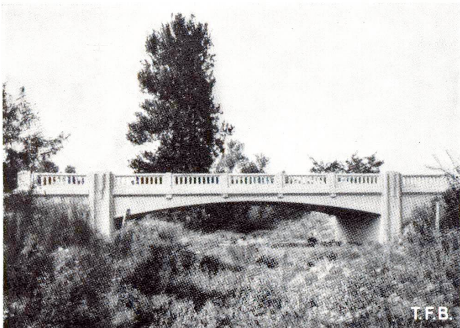
Fig. 8 Pont sur ruisseau en Amérique
