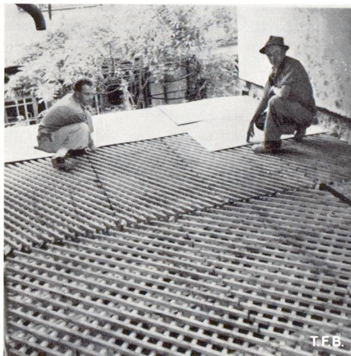
Fig. 2 Panneau de coffrage en lattis et planches minces
