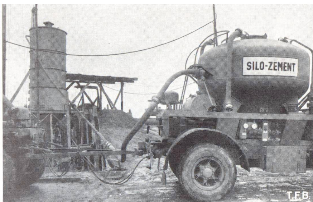
Fig. 3 Remplissage d'un silo du chantier au moyen d'un camion avec remorque de 2 \times 5,5 t. Les manomètres et vannes de l'installation à air comprimé du camion sont bien visibles
