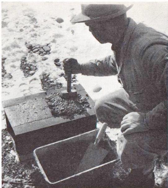
Fig. 5 Damage à la massette
