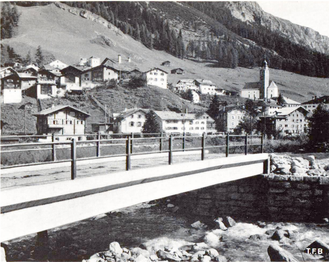
Fig. 3 Petit pont en poutres préfabriquées en béton. Portée 13 m
