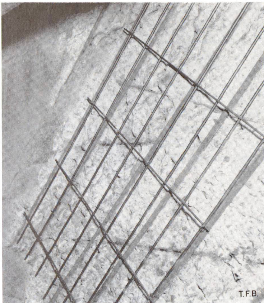
Fig. 5 Si la surface à réparer est grande, on y place une légère armature
