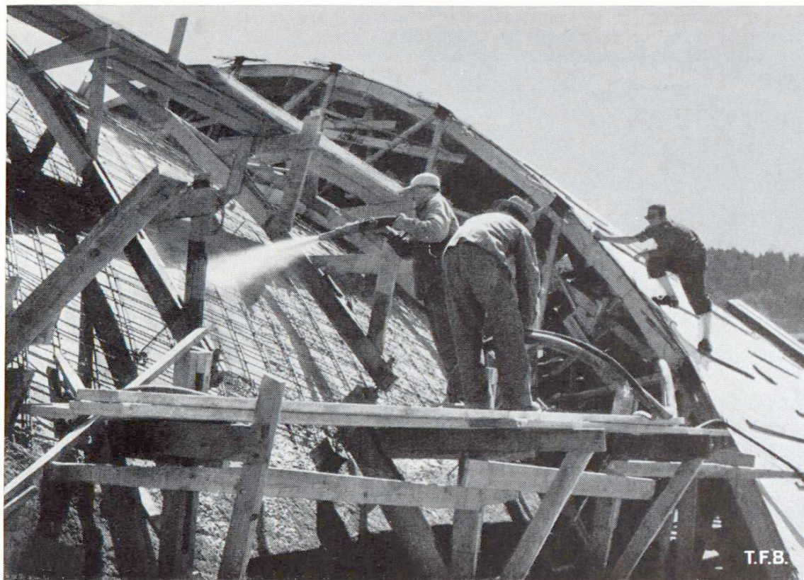
Fig. 5 Les voiles sont bétonnés au canon à ciment, sans coffrage extérieur (CP 325, bal- last 0—20 mm); leur épaisseur croît de 7 à 12 cm de la clé aux naissances
