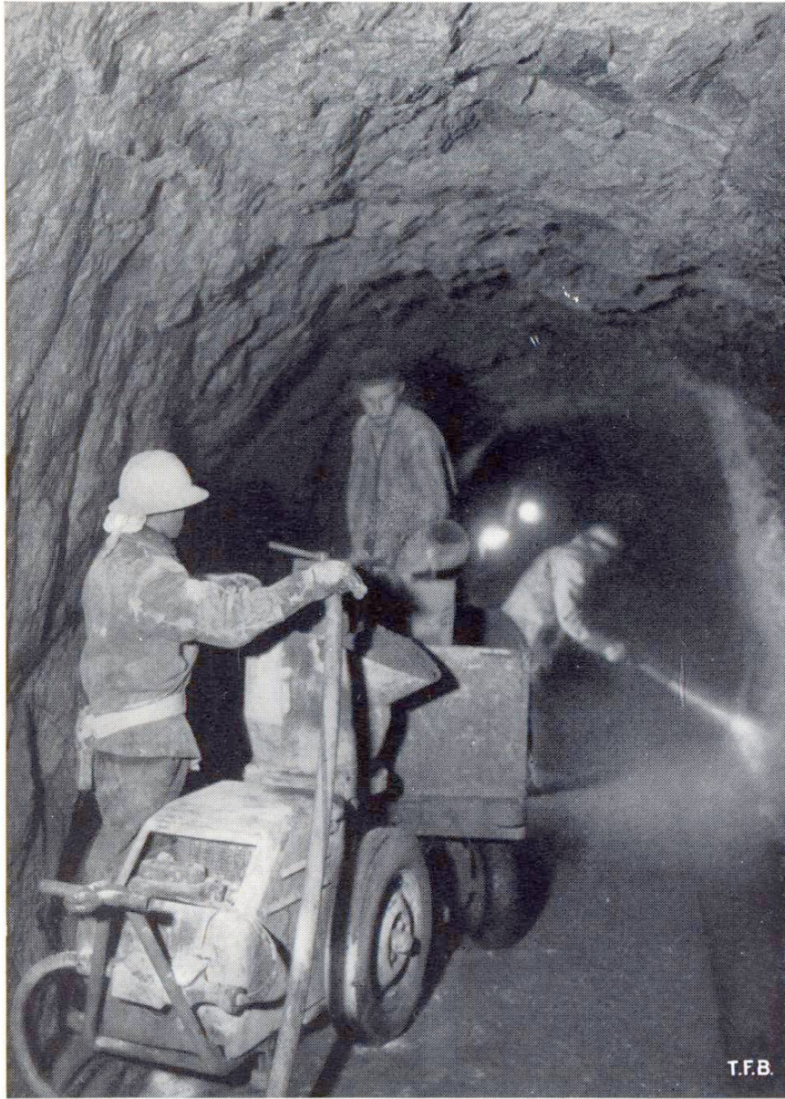
Fig. 1 Installation de galerie pour béton projeté
