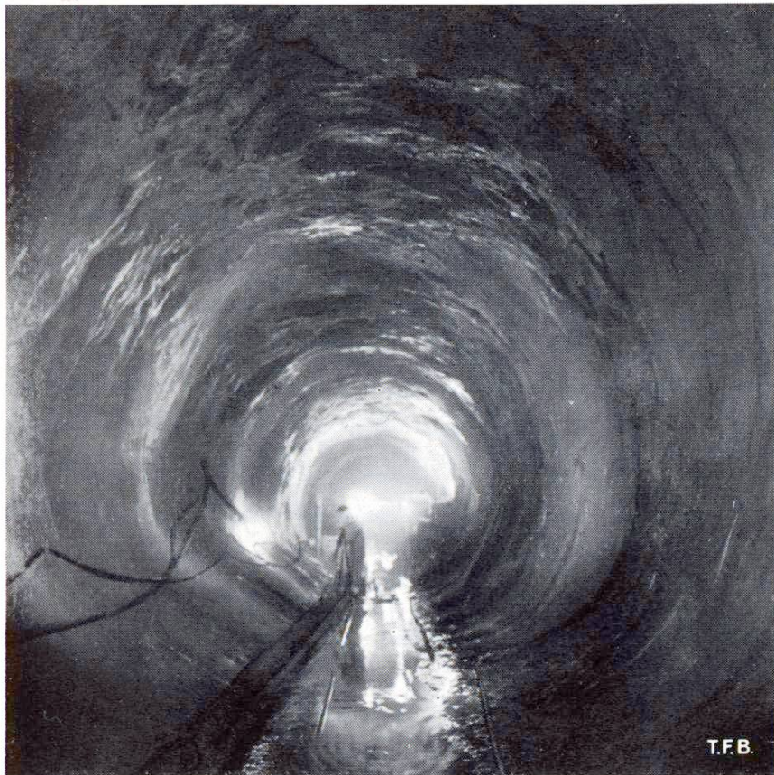
Fig. 5 Revêtement en béton projeté dans la galerie en charge Grande Dixence - Fionnay. Longueur 3,3 km. Pression maximum 22 atm.
