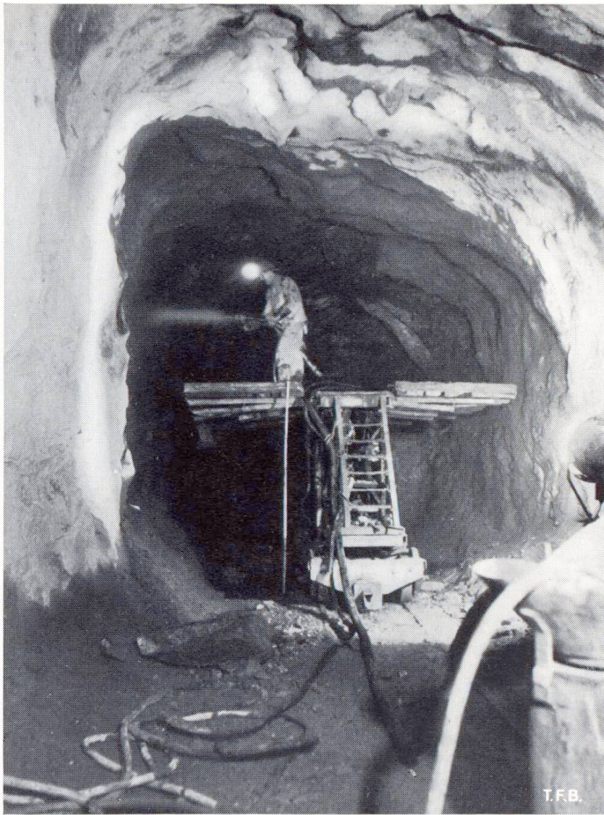
Fig. 2 Consolidation de rocher jusqu'au front d'attaque d'une galerie, en béton projeté. (Photo Forces motrices de la Maggia S. A.)
