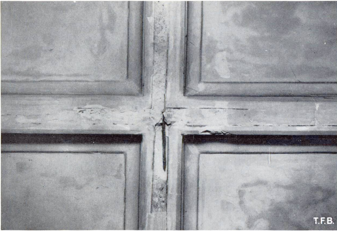
Fig. 4 Détail du plafond sur rez montrant le remplissage de béton entre les caissons de plâtre et l'armature qui y est placée
