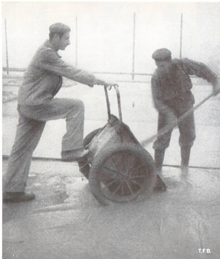
Fig. 5 Mise en place de béton cellulaire pour l'isolation d'une toiture.
