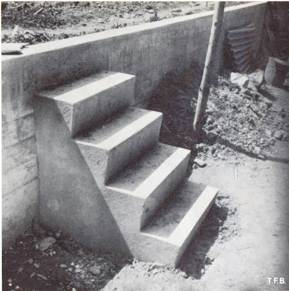
Fig. 3 et 4 On a souvent recours au béton pour de nombreux aménagements
