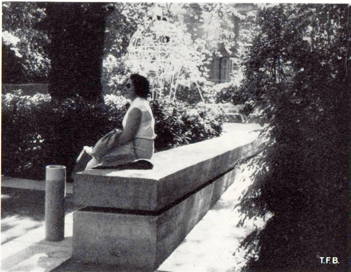
Fig. 8 Muret en béton sans crépi
