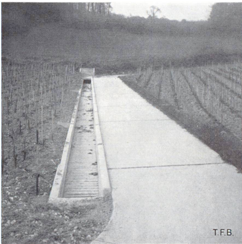
Fig. 6 Dans un vignoble de la Côte, chemin en béton longeant un canal d'évacuation des eaux
