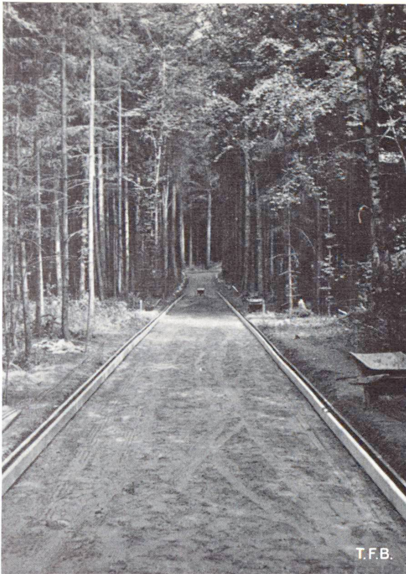
Fig. 1 Forme de la fondation et coffrages préparés pour le bétonnage d'un chemin forestier. Canton de Vaud
