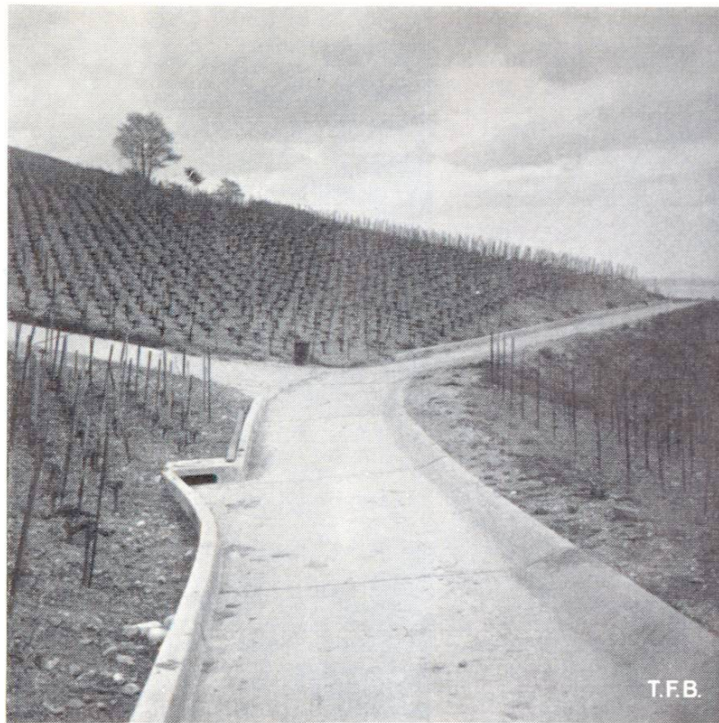
Fig. 5 Dans nos vignobles, on a déjà construit plusieurs kilomètres de chemins en béton destinés avant tout à la lutte contre l'érosion. En cas d'orage, les eaux de ruissellement sont arrêtées par les chemins et coulent sur leur surface dure sans les dégrader. Elles y déposent la terre fertile qu'elles avaient arrachée au coteau, terre que le vigneron pourra récupérer et remettre en place
