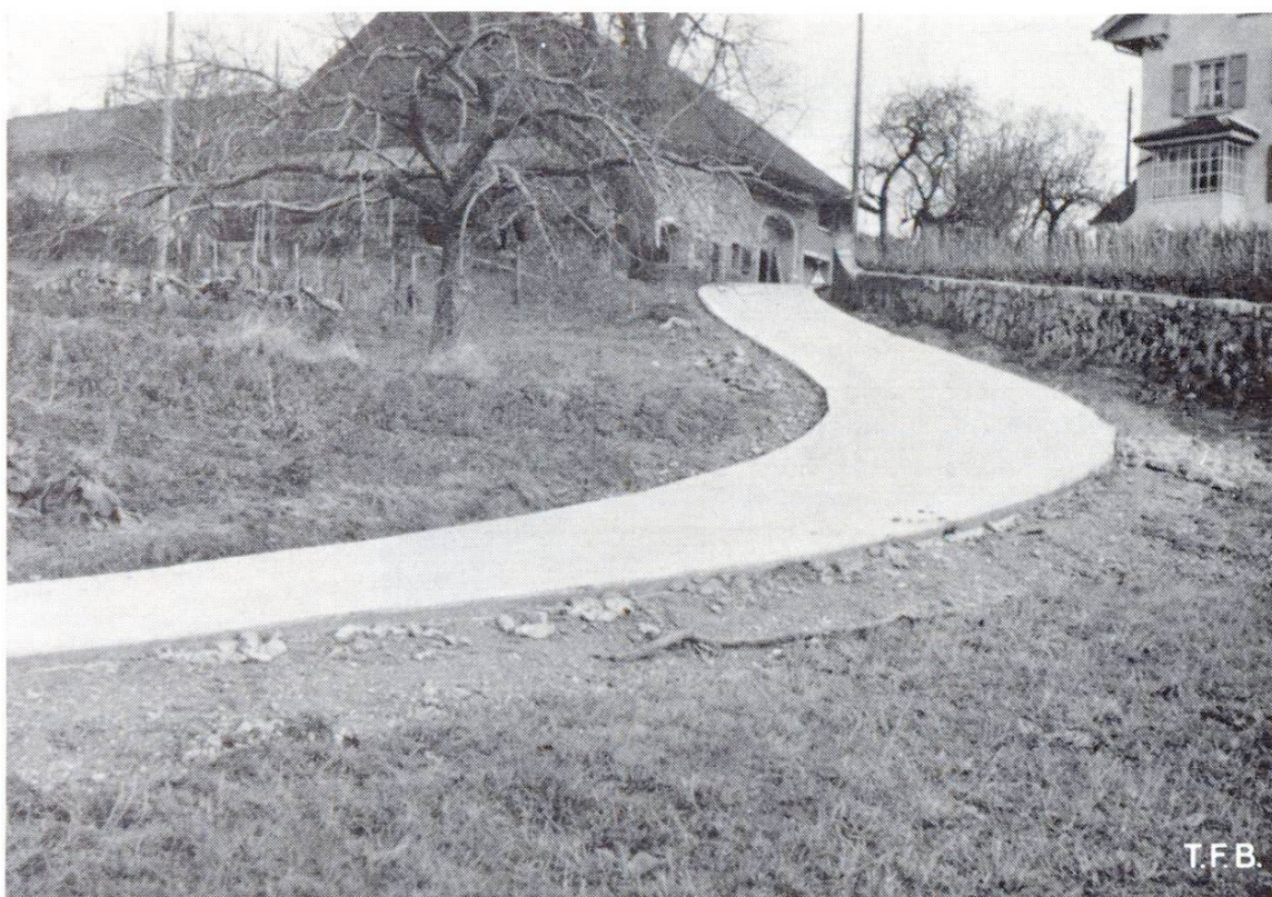
Fig. 8 Chemin en béton donnant accès à une ferme. On voit que les courbes en rampe n'offrent pas de difficultés particulières
