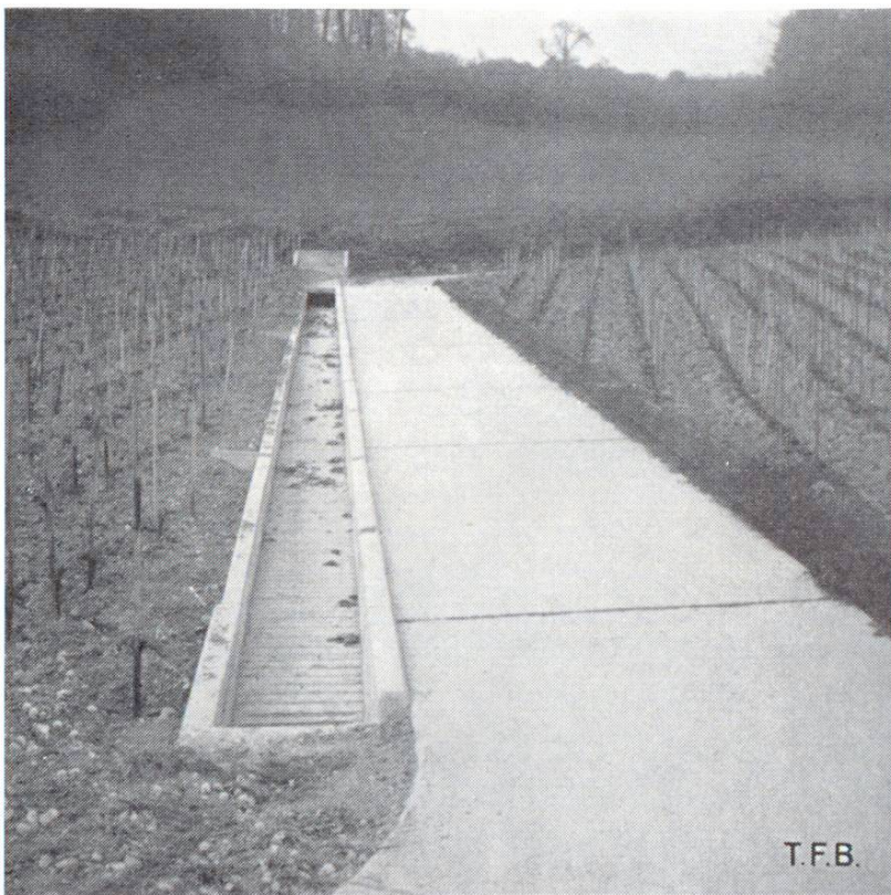
Fig. 6 Dans un vignoble de la Côte, chemin en béton longeant un canal d'évacuation des eaux
