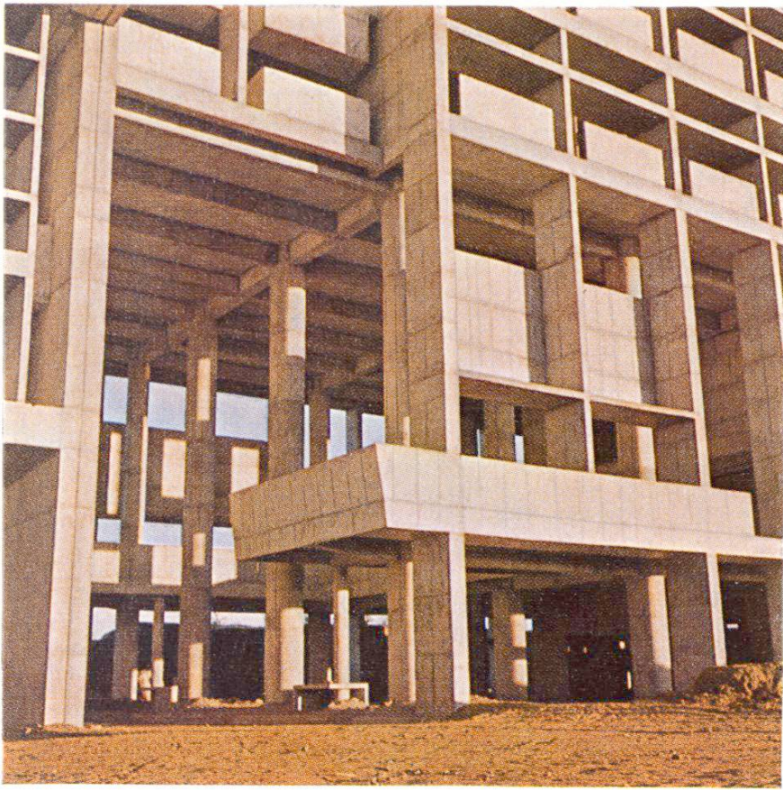
Fig. 6 Détails de la façade du Secrétariat. Des proportions harmonieuses et un emploi judicieux des coffrages confèrent au béton une véritable noblesse
