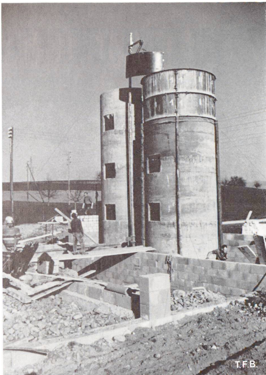
Fig. 2 Bêtonnage de silos tours au moyen de coffrages glissants
