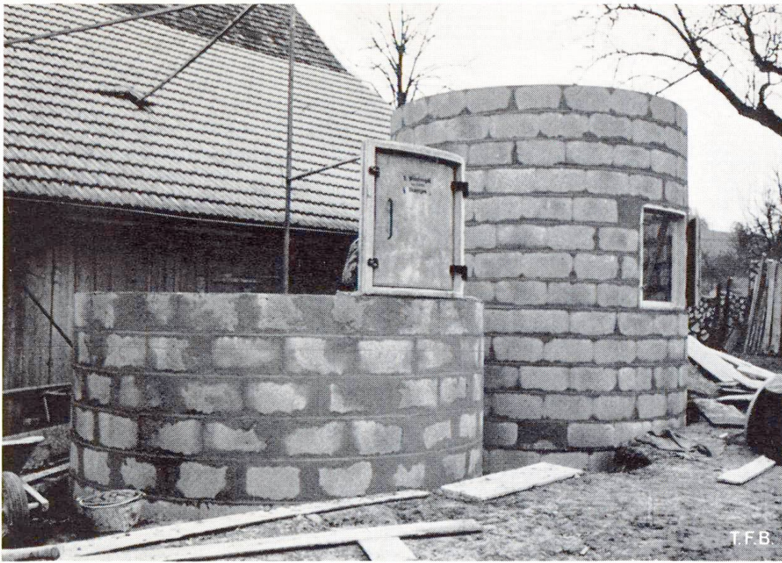
Fig. 3 Construction de silos en éléments préfabriqués
