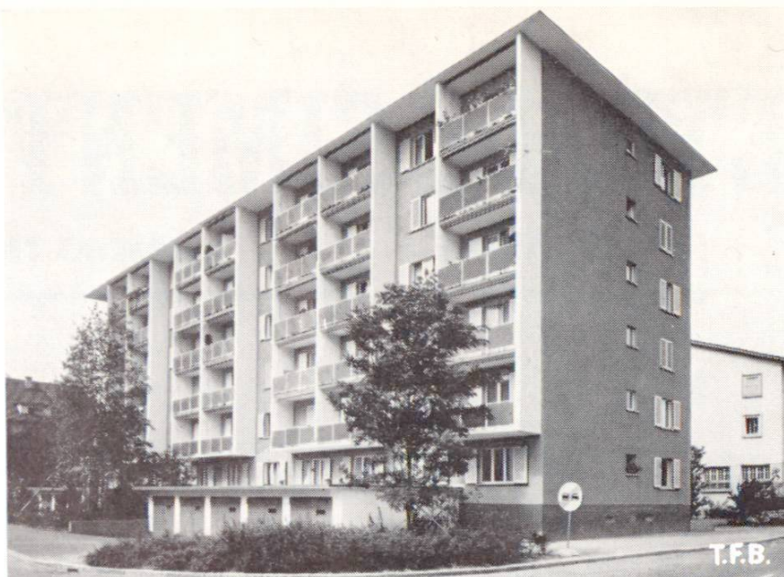
Fig. 1 Bâtiment locatif à Dietikon (ZH) construit entièrement en béton préfabriqué sur le chantier (Projet et exécution: D. Lanfranconi, Zurich).
