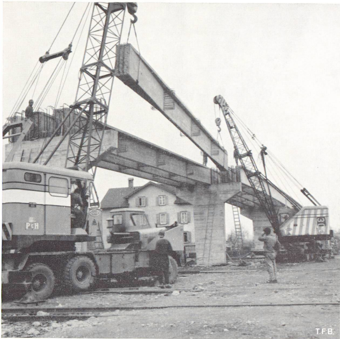
Fig. 4 Montage des poutres.
