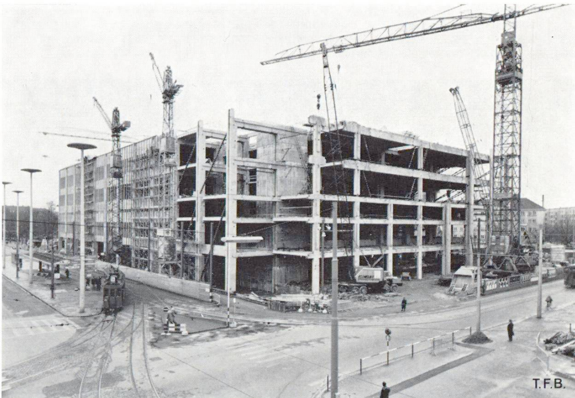
Fig. 11 Etat des travaux le 24 mars 1964, peu après la fin du montage.
