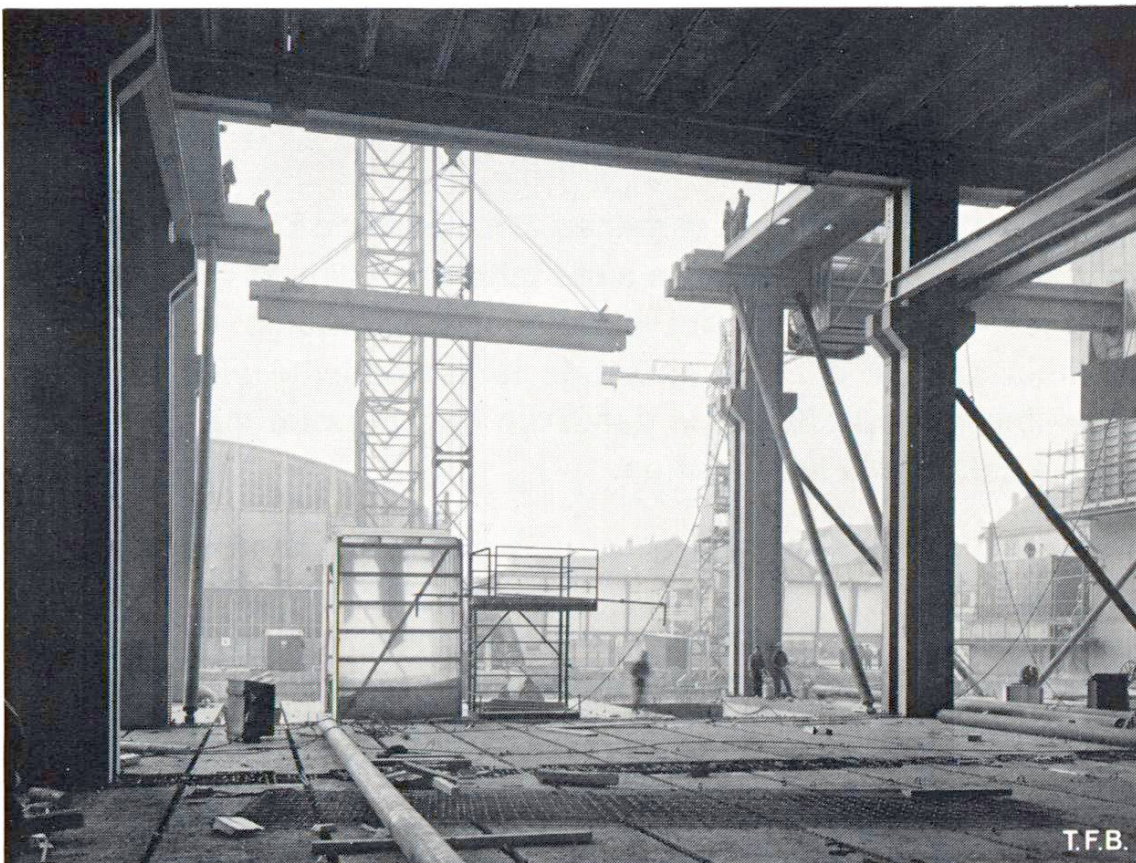
Fig. 6 Mise en place d'une poutre sur les consoles des piliers. Le montage se faisant à partir du sol de la cave, la hauteur maximum de levage fut de 34 m.
