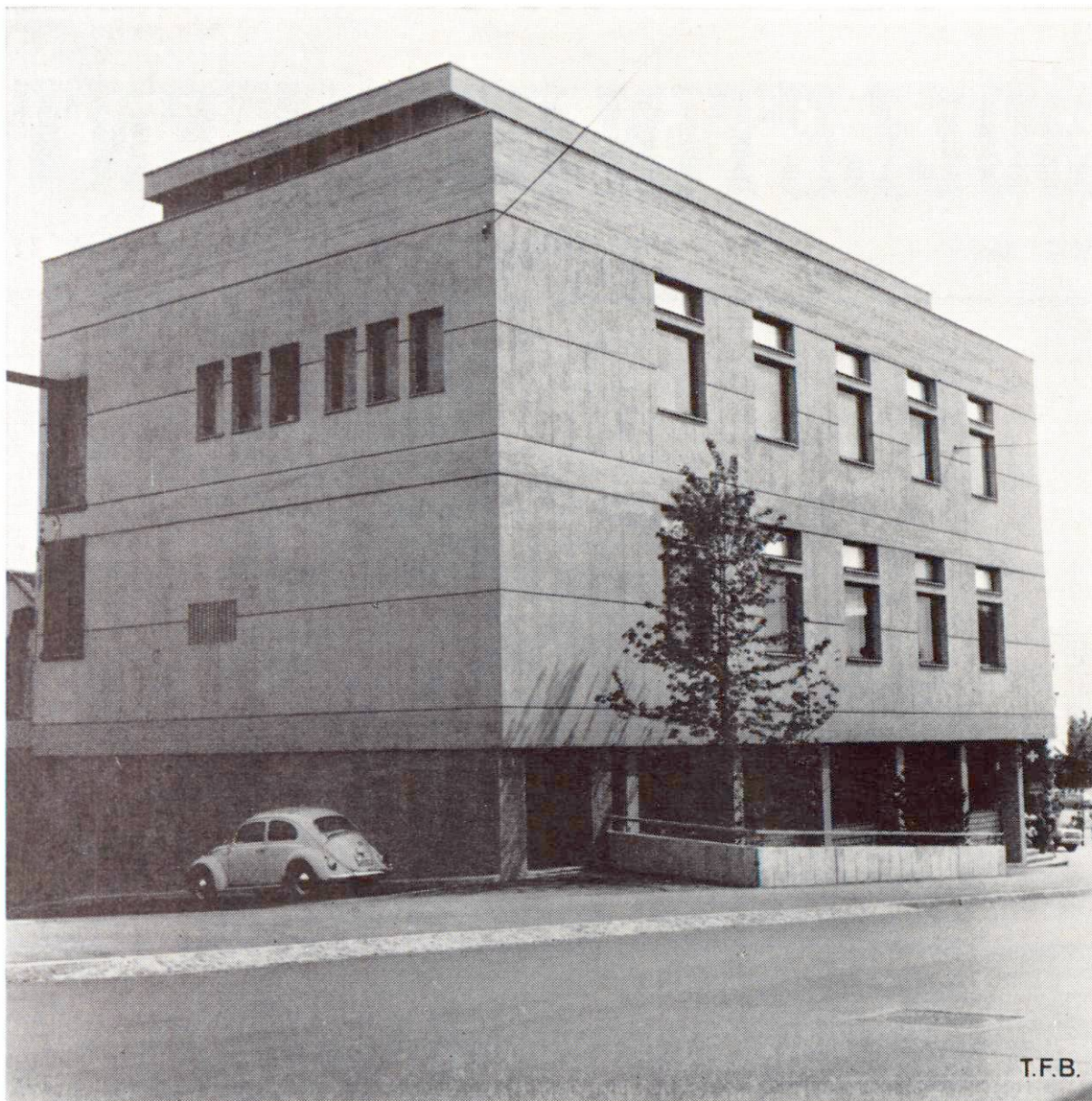
Fig. 10 Construction en béton apparent avec joints de travail fortement marqués.
