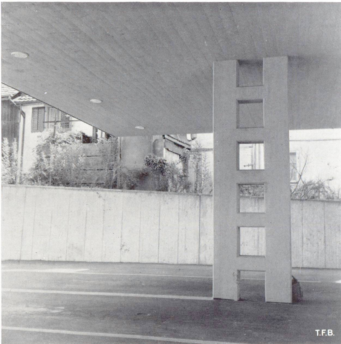
Fig. 16 De tels piliers composés, en béton apparent, exigent un coffrage spécialement bien étudié et une mise en place du béton particulièrement soignée.
