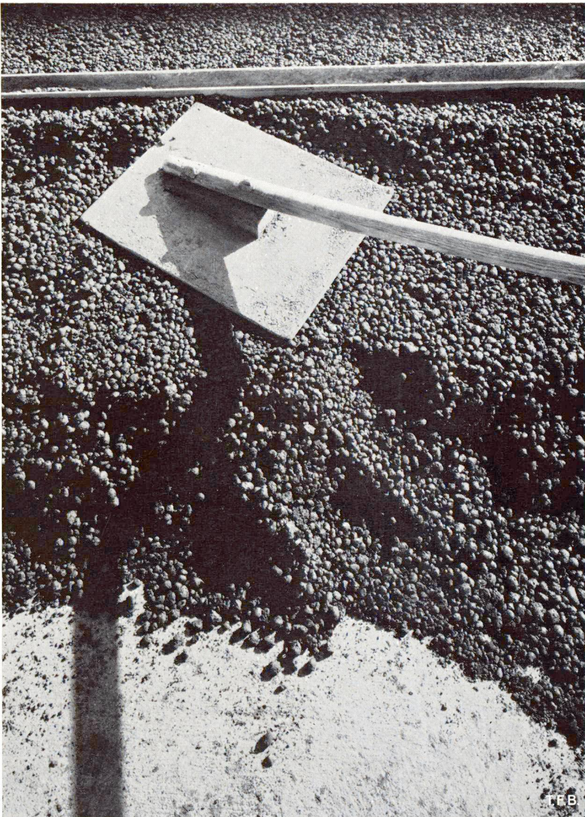
Fig. 9 Serrage d'un béton d'isolation au Leca.
