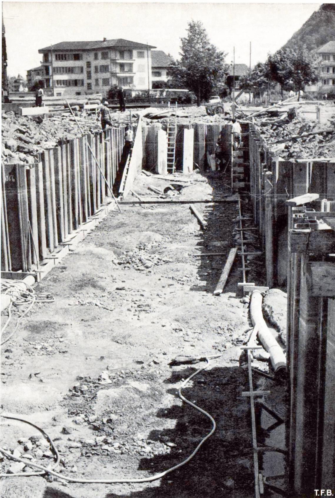
Fig. 7 Passage inférieur pour piétons. Vue de la dalle en béton immergé après assèchement, inégalités env. 20 cm.
