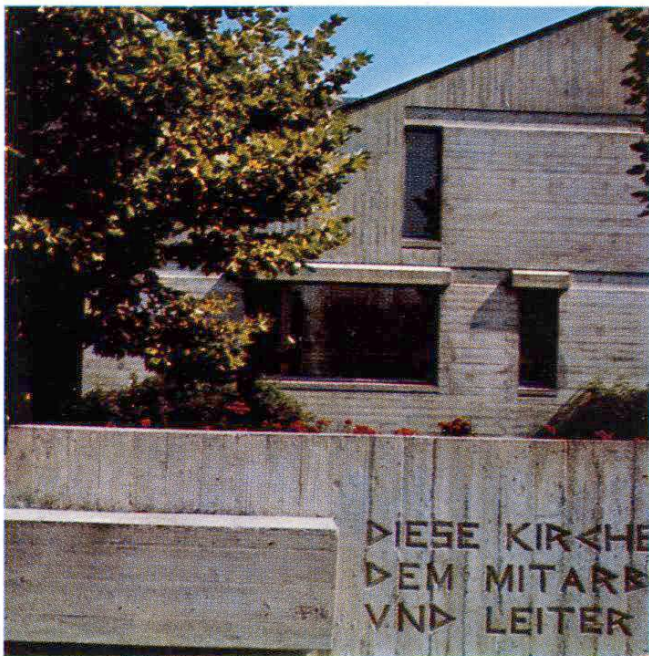
Détail de la façade
