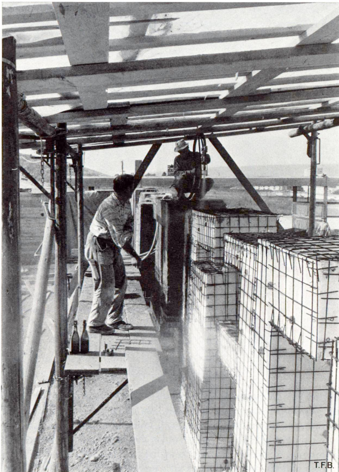
Fig. 2 Mur avec reliefs artistiques. Noyau en blocs de mousse synthétique de forme conve- nable. Armature en treillis d'acier à 2 cm du support.
