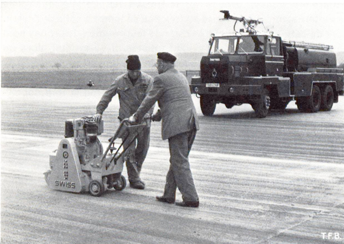
Fig. 2 La machine en action sur une piste d'aérodrome.
