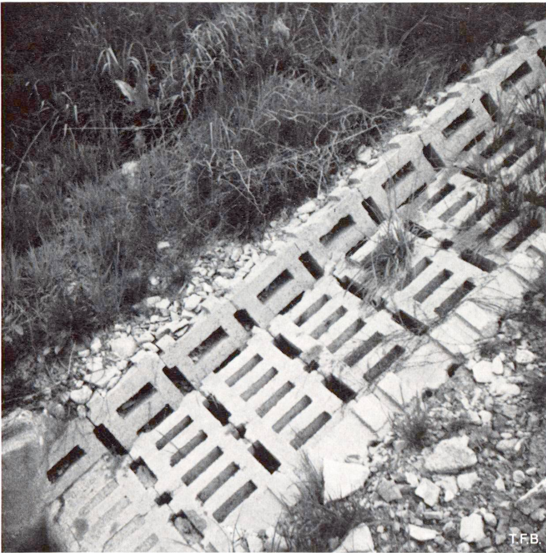
Fig. 7 Exemple d'un fossé d'évacuation des eaux au pied d'un talus de route.
