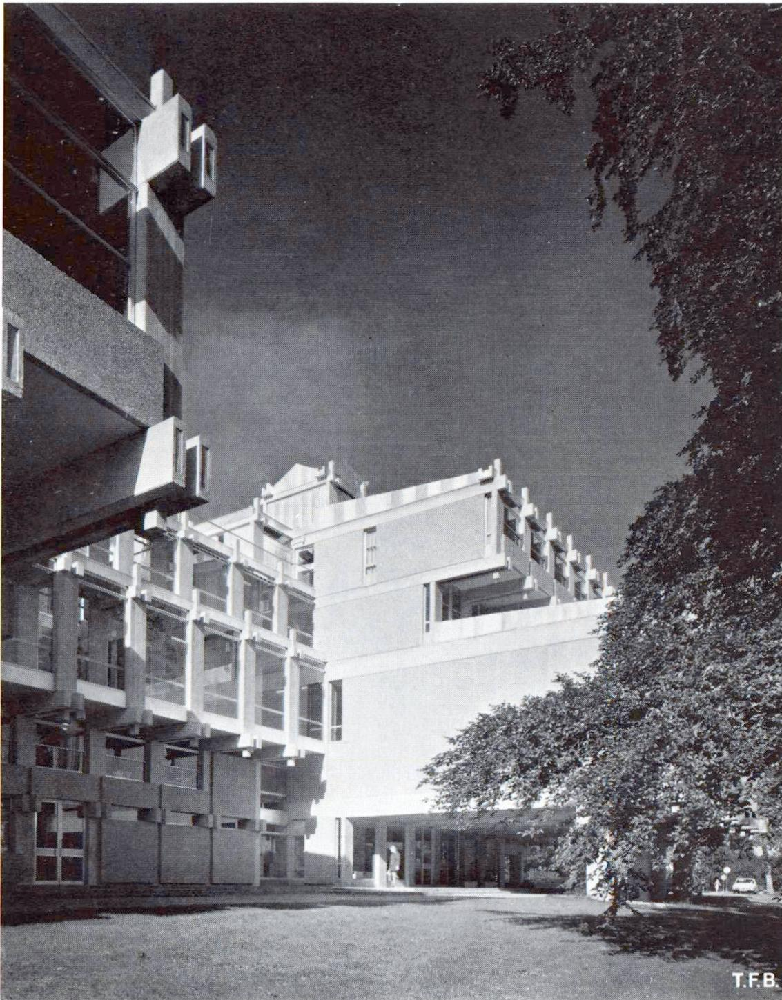
des piliers et des poutres de  $200 \times 600$  mm. Les plus longues poutres et celles qui sont en encorbellement sont en béton précontraint. La surface des poutres et des piliers est lisse et leur béton légèrement teinté en brun-jaune. Les dalles de façade ont une surface en béton lavé avec des granulats ronds allant du brun foncé
