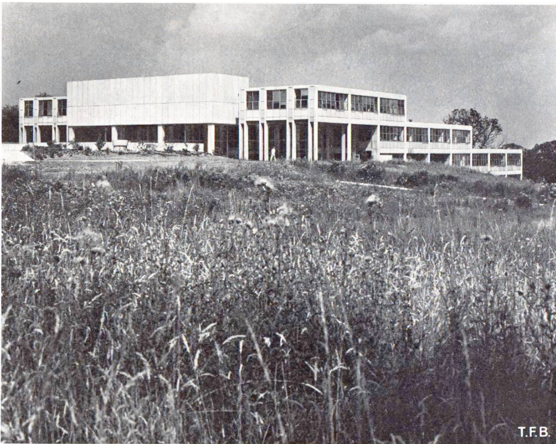
Fig. 2 Vue latérale. Le bâtiment est en escaliers pour épouser la pente du terrain descendant vers l'arrière. A la partie supérieure se trouvent la bibliothèque (dans le cube sans fenêtres), l'administration et les laboratoires. Les étages inférieurs abritent les salles de séminaires et les ateliers.
