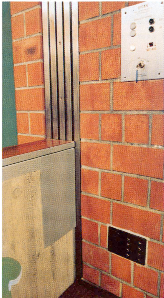
6 Détail du raccordement latéral avec le rail de guidage au milieu et les 4 rainures des joints d'isolation. A droite en haut, les boutons de commande.
