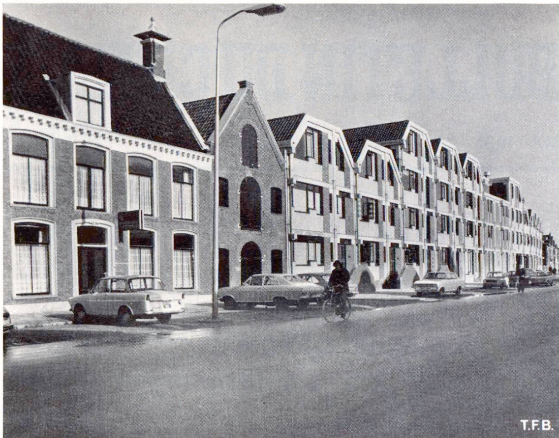
Fig. 1 La façade du nouveau bâtiment est bien adaptée à celle des vieilles maisons, le long de ce qui fut un ancien canal.
