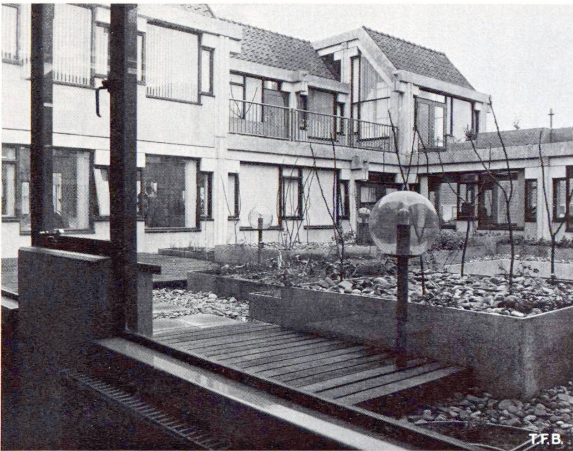
Fig. 3 Groupe de logements donnant sur les jardins aménagés sur un toit.
