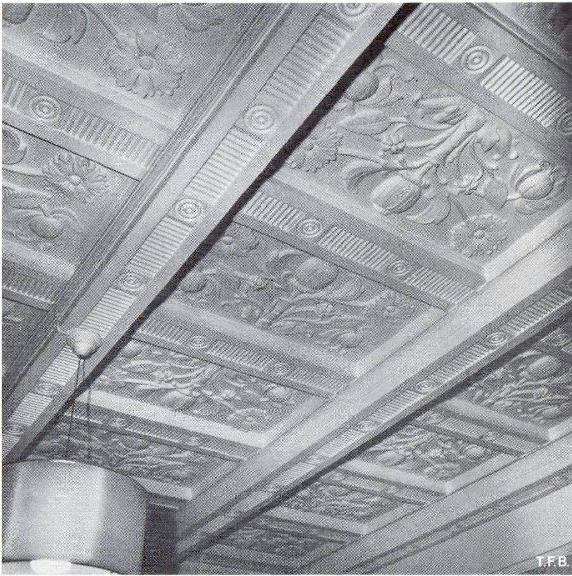
2 Plafond d'une chambre constitué par des sommiers en bois entre lesquels sont placées des plaques de béton avec décorations moulées en forme de fleurs.
