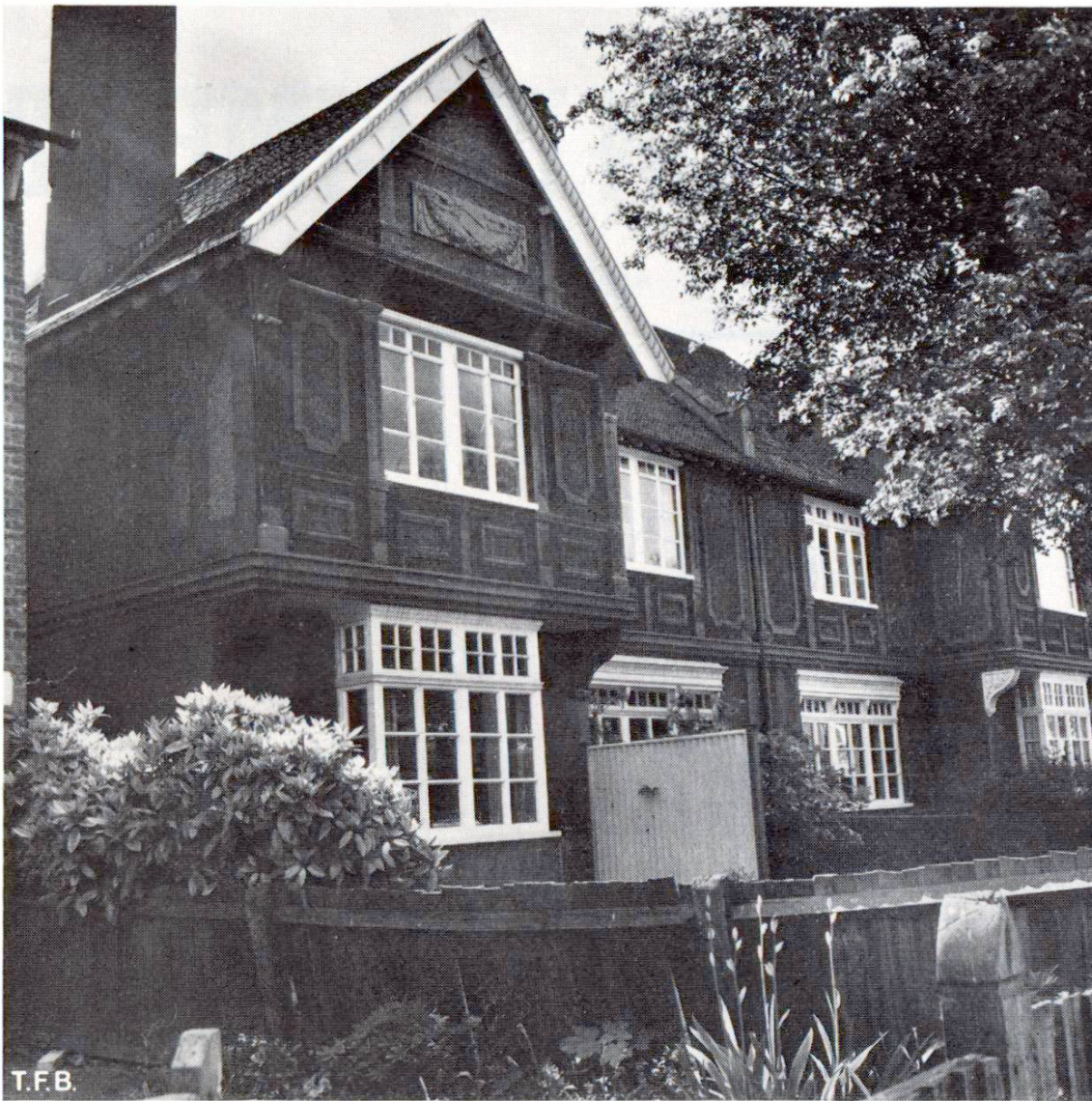
1 Maison double à Croydon, au sud de Londres, construite en 1882 par le procédé Lascelles. Sa teinte est brun foncé et son architecture plaisante. Les motifs décoratifs de la façade ont été imprimés par moulage lors de la préfabrication des plaques en béton. Les parapets, corniches, sommiers et plaques décoratives sont aussi en éléments préfabriqués.
