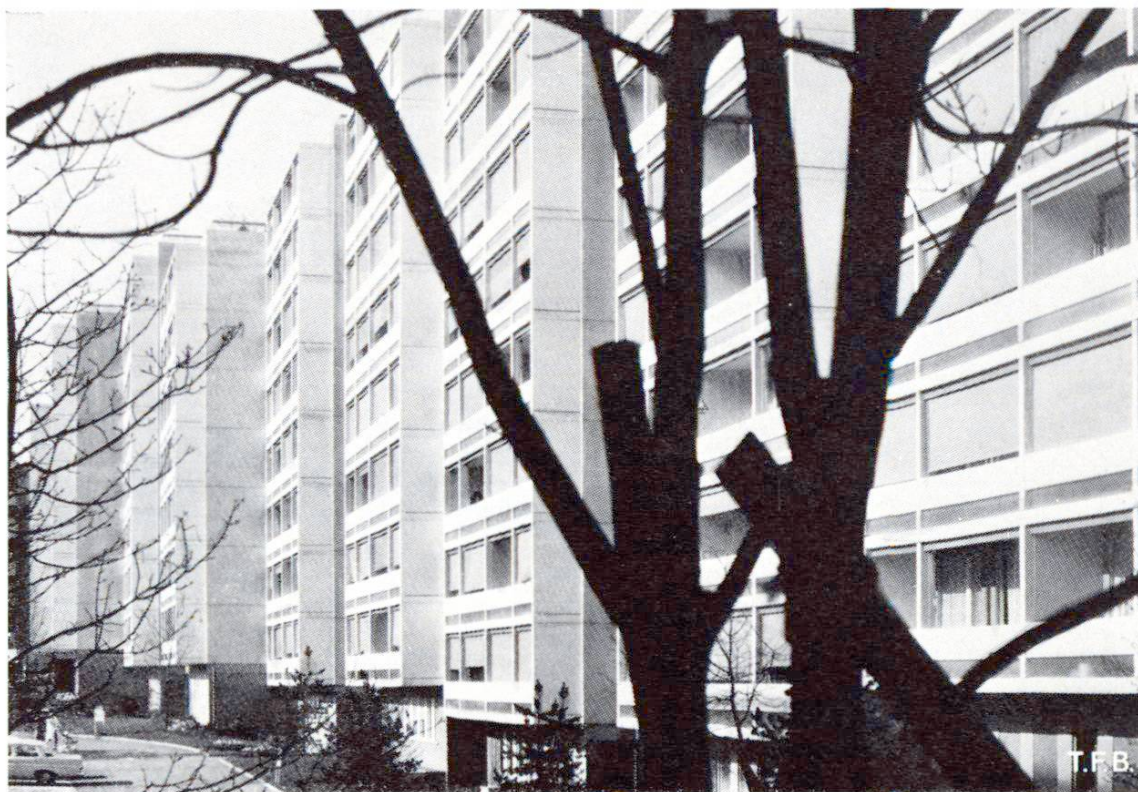
Fig. 5 Immeuble locatif moderne en éléments de béton lisse très soigneusement fabriqués et mis en place
