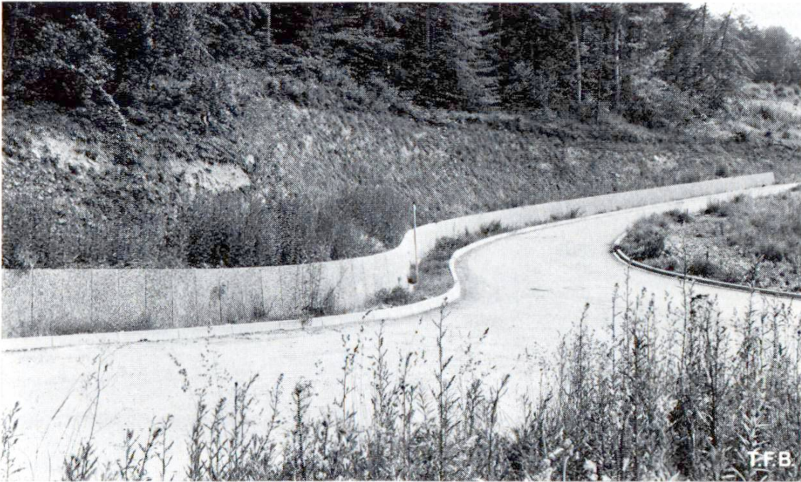
Fig. 4 Des éléments en L placés côte à côte forment un petit mur de pied de talus. Les surfaces apparentes sont en béton lavé.
