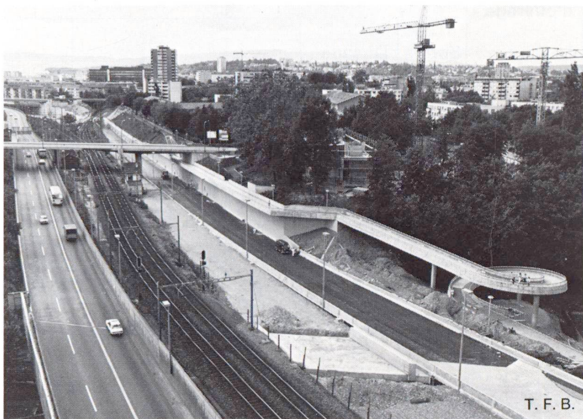
Fig. 1 Vue de l'aménagement du triangle routier de Gellert, Bâle. Route automobile, chemin de fer, passage pour piétons.
