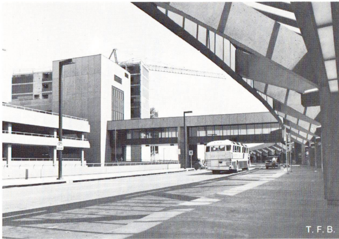
Fig. 7 La route d'accès surélevée vue d'une des entrées de l'aérogare. A gauche, le bâtiment de parking ainsi que les passerelles.
