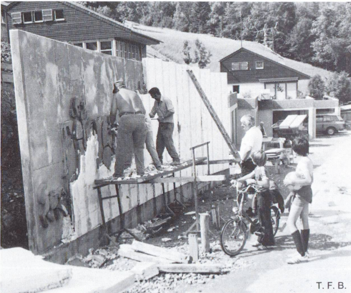
Fig. 7 Le relief apparaît. Le moulage est visiblement réussi.
