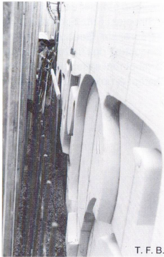
Fig. 2 Le moule s'appuyant contre une paroi en bois visible au fond.
