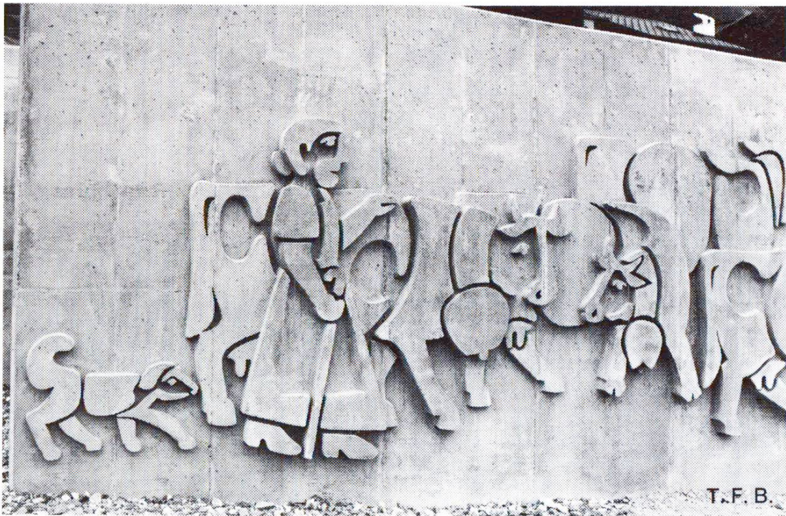
Fig. 9 Cette image de la fin du cortège alpestre montre l'aspect caractéristique du béton tel qu'il a été réalisé ici. On se rend compte également du soin et de la précision qu'il a fallu apporter au découpage des différentes parties du moule et à leur mise en place.
