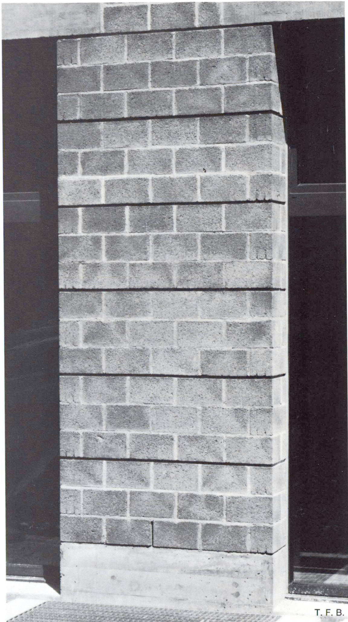
Fig. 8 Maçonnerie apparente en béton dans un assemblage spécial.
