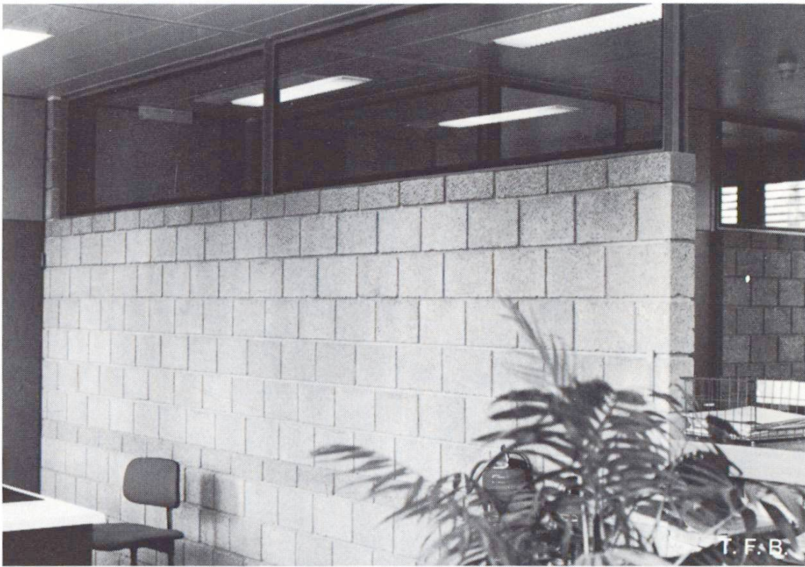
Fig. 14 Maçonnerie apparente en béton combinée avec cadre de fenêtre en acier.
