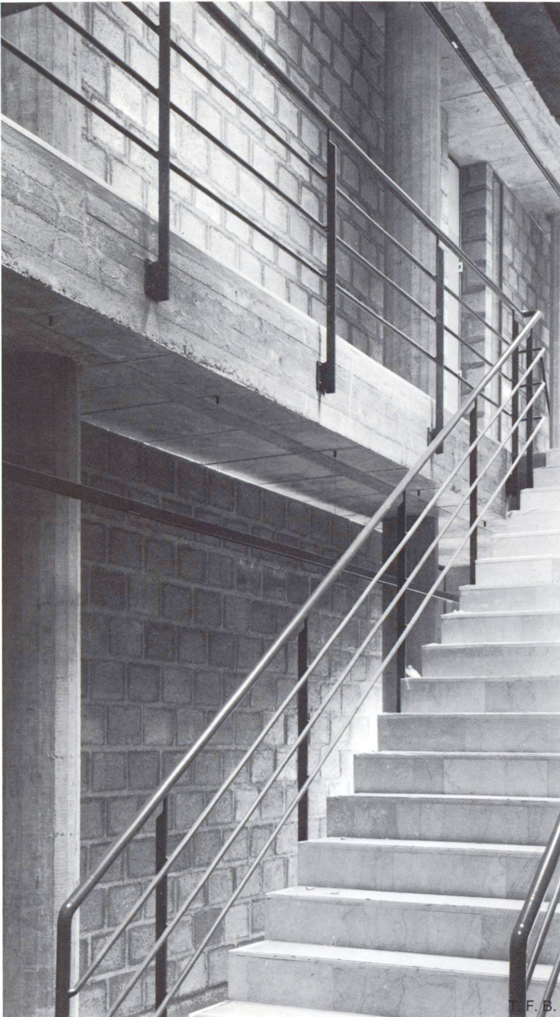
Fig. 5 Maçonnerie apparente en béton pour le bâtiment de la direction d'une fabrique.
