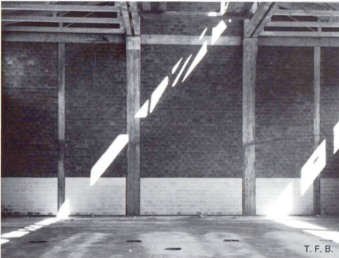
Fig. 6 Maçonnerie apparente en béton dans une usine.
