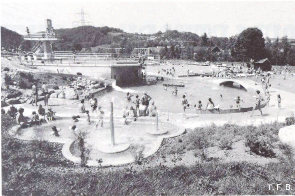
Fig. 1 Etablissement de bain de Birmensdorf. Bassin pour plongeurs (surélevé), bassin pour non-nageurs, douches en champignon.
