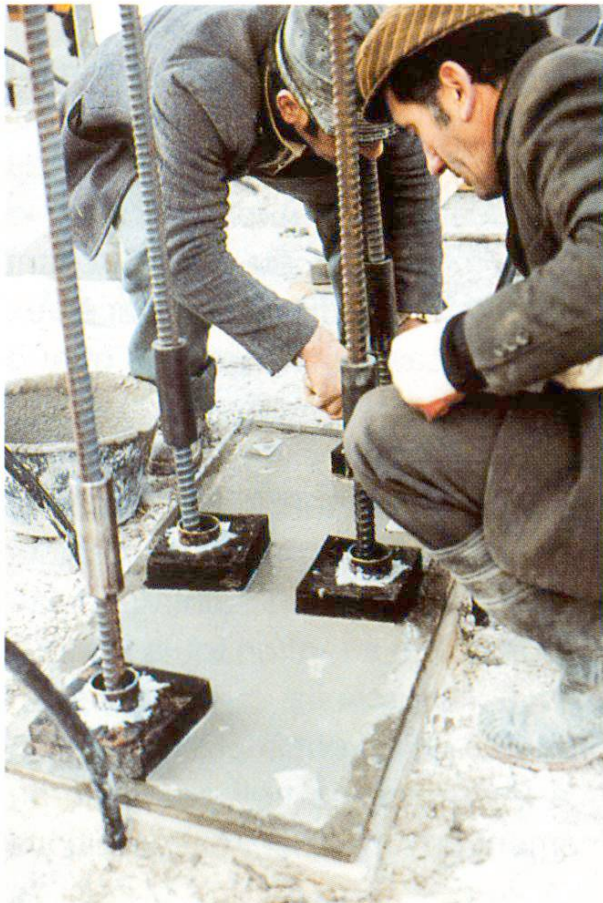
Ancrage des colonnes dans le sol. Précontrainte: Spann-Stahl AG, Hinwil. 10
