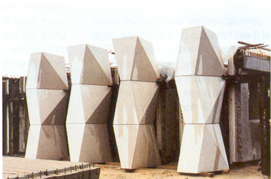
Éléments types A et B prêts pour le transport sur le chantier. 7
