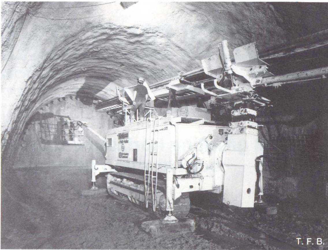
Fig. 1 Avancement en calotte dans un terrain meuble. Foreuse pour le jet grouting.
