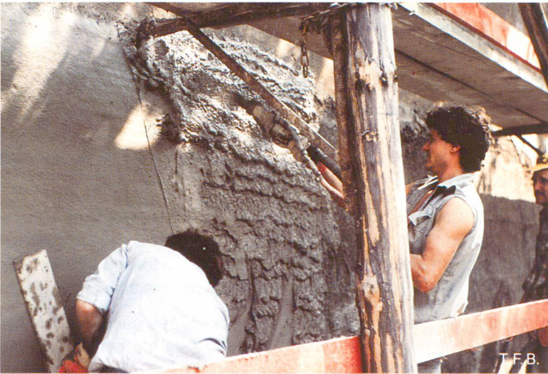
Fig. 6 Rénovation d'une façade par un crépi classique de sable 0-4 mm et de chaux hydraulique. Mortier pompé projeté au pistolet. Le réglage à la latte forme une fine couche lustrée qui doit être enlevée.
