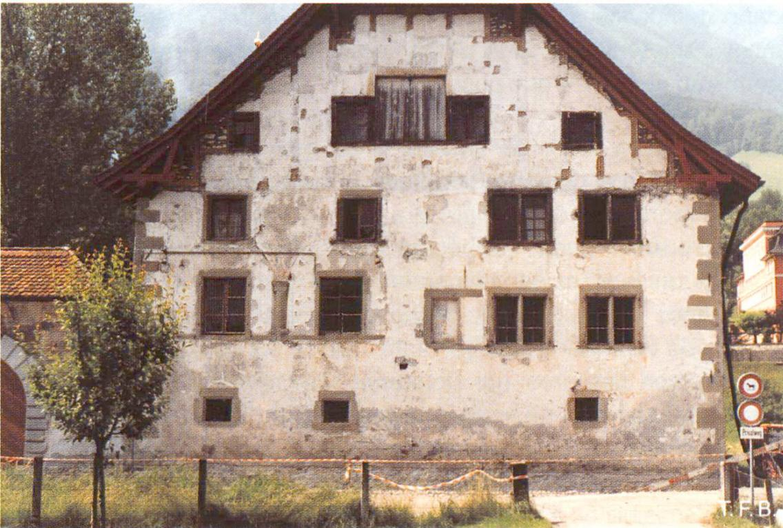
Fig. 2 L'humidité montant à partir des fondations laisse des traces bien visibles (Maison de Winkelried, Stans, façade nord, juillet 1987).
