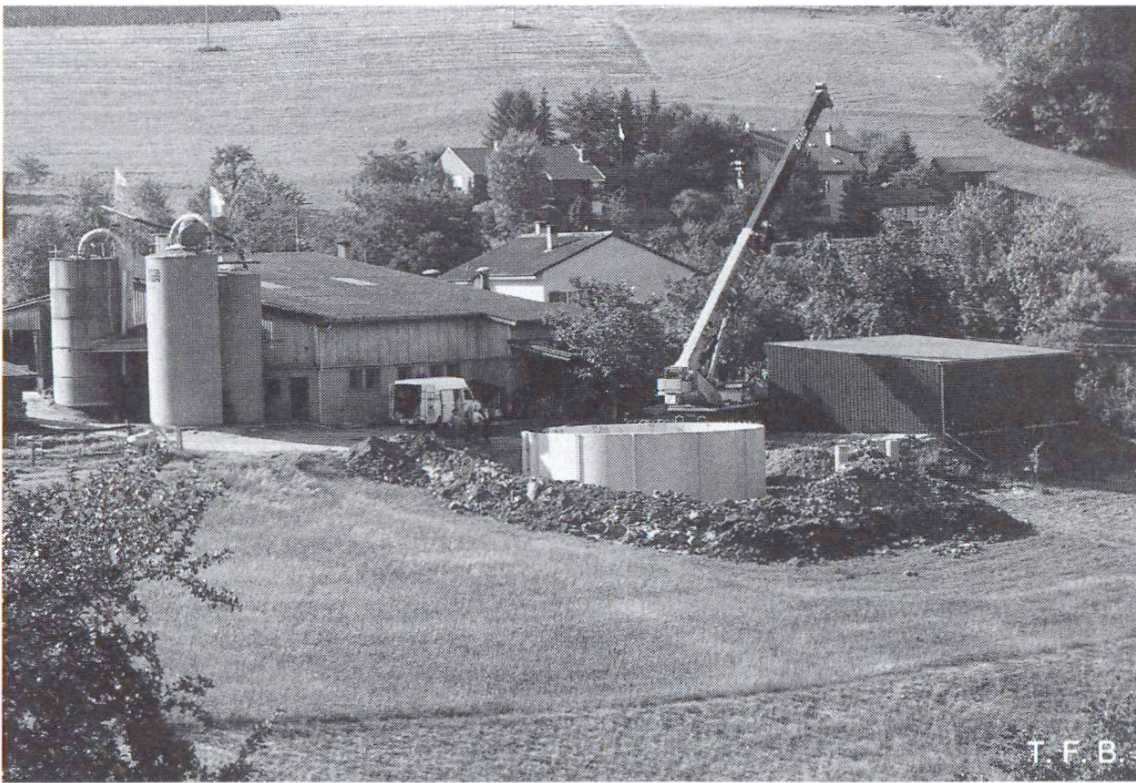
Fig. 14 Fosse à purin après montage des éléments. Remblayage derrière la paroi au moyen des matériaux d'excavation et aménagement des talus. Pose d'une clôture dans le cas où la paroi ne dépasse pas de plus de 1 m le niveau du terrain (Buckten, canton de Bâle campagne).
