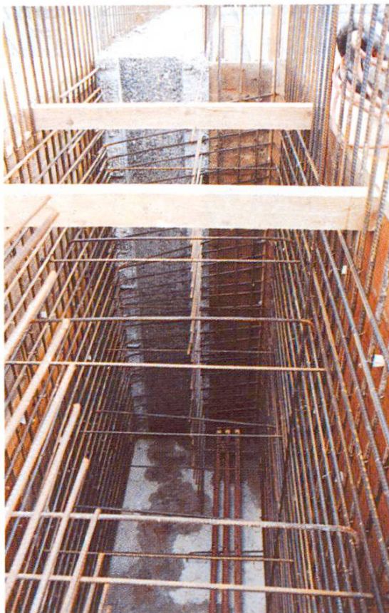
Fig. 5 Mur préparé pour une étape de bétonnage. Nettoyage et humidification.
