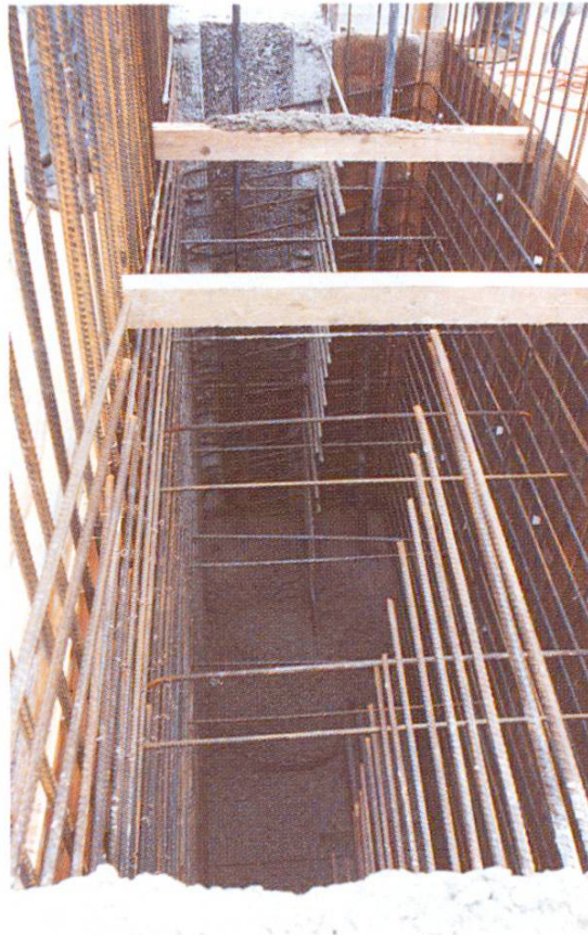
Fig. 6 Début des travaux de bétonnage. On voit les robustes écarteurs de l'armature.
