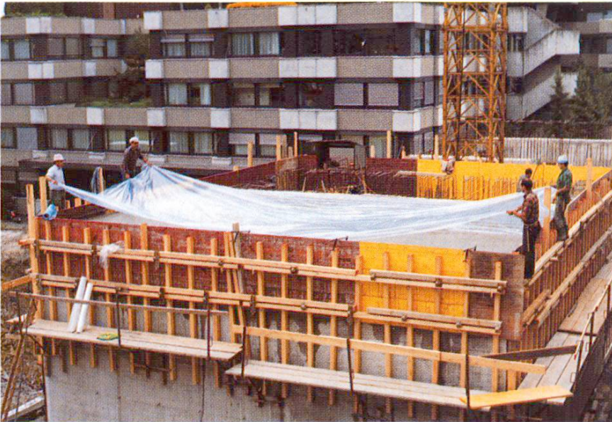
Fig. 13 Recouvrement avec une bâche en plastique.
