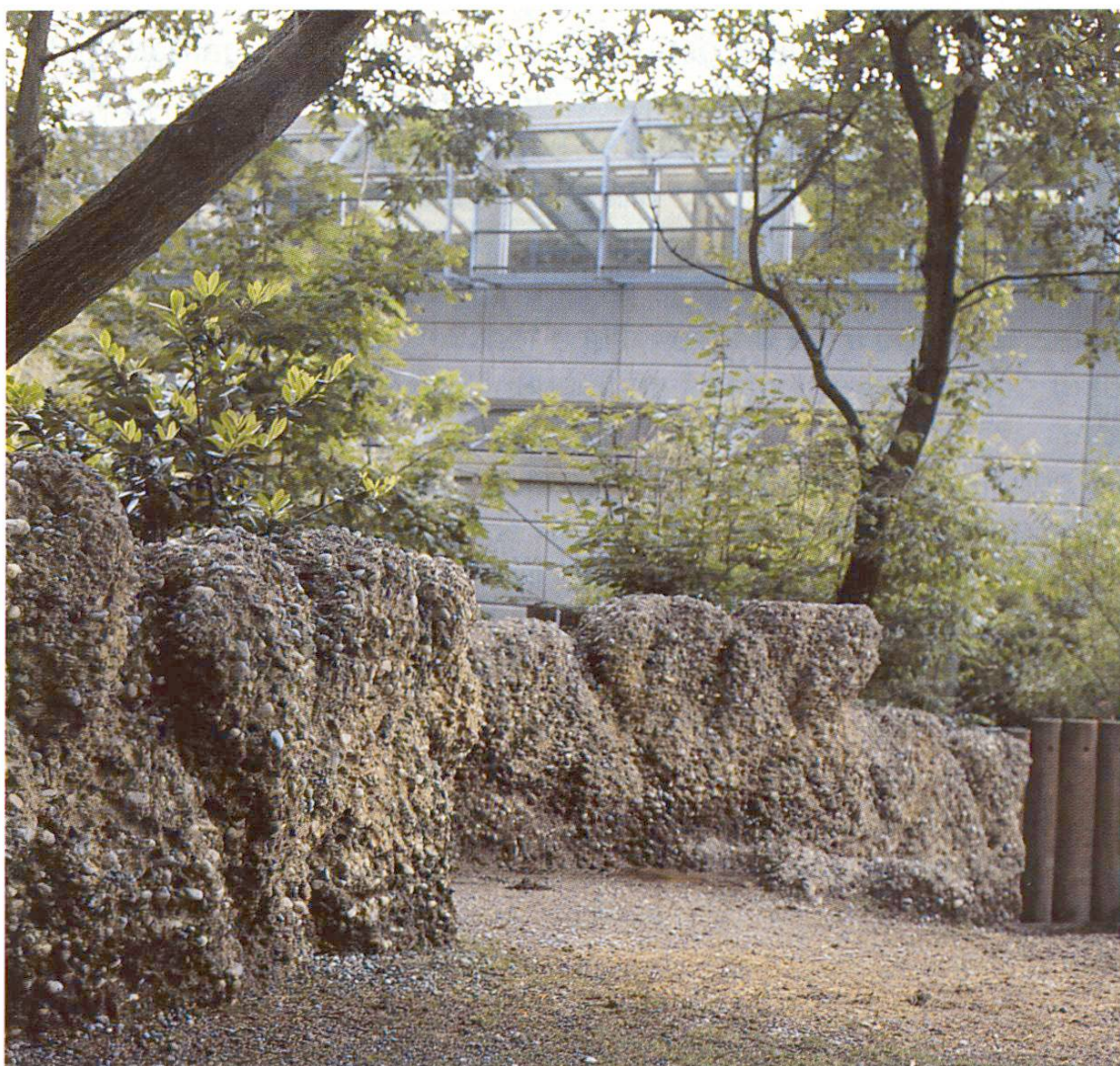
Fig. 1 Poudingue artificielle servant de mur de fermeture dans un des enclos d'une installation de plein air.
