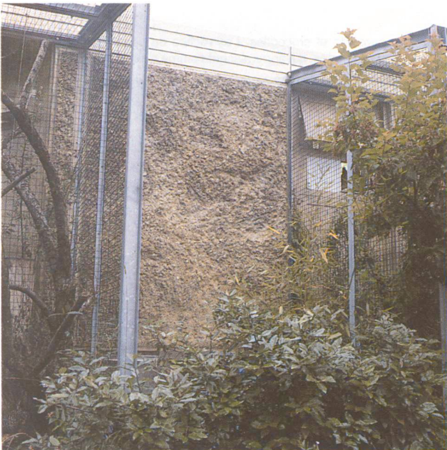
Fig.8 Eléments de façade préfabriqués en usine. L'arrière-plan semi-naturel remplaçant une surface de béton lisse offre aux oiseaux la possibilité de se percher et de nidifier.
