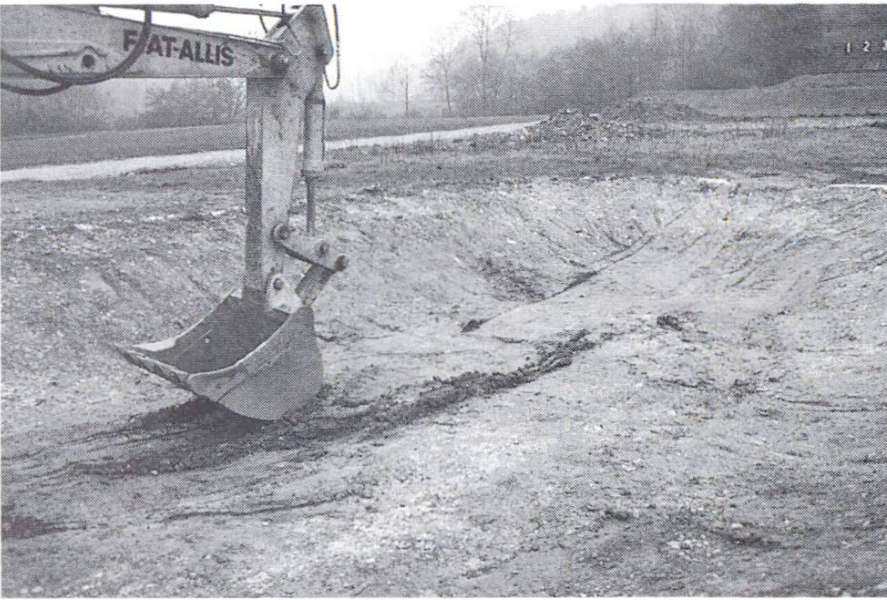
Fig. 8 Creusage pour un étang, au moyen d'un engin usuel
