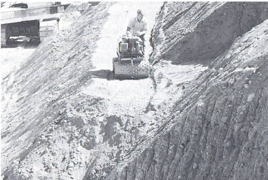
Fig. 16 Pour les berges escarpées, les couches sont mises en place horizontalement (travaux exécutés avec des bernes comme dans les grands chantiers)
