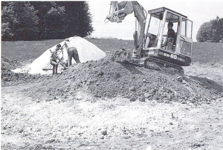
Fig. 11 Malaxage avec un petit excavateur. Dépôt recouvert d'une feuille en plastique
