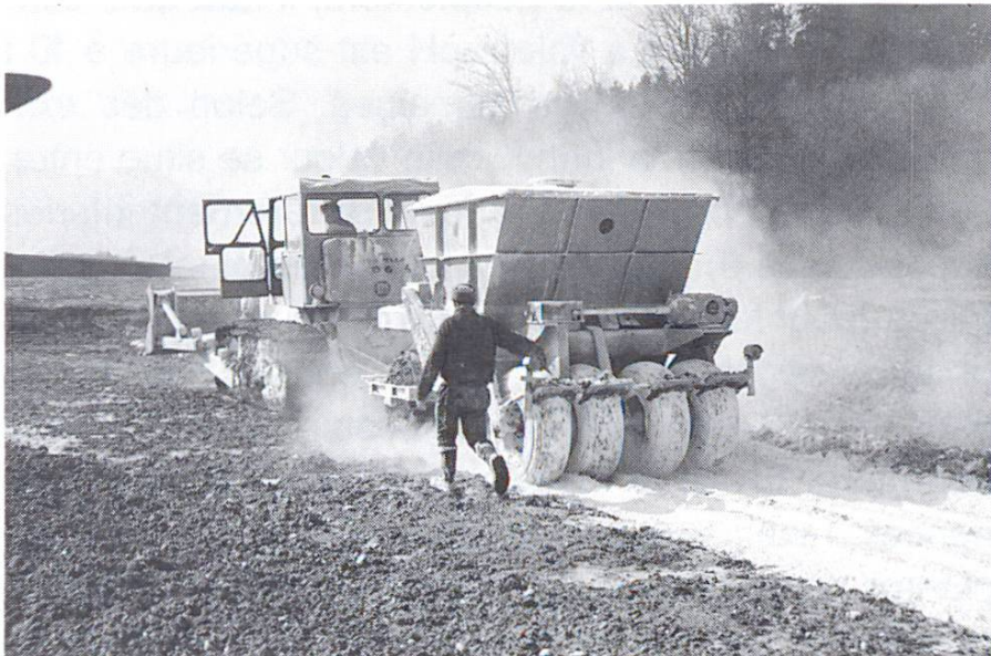
Fig. 10 Epandage à la machine
