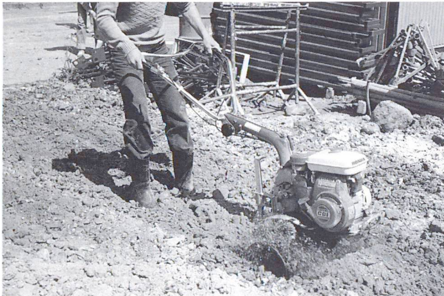
Fig. 12 Malaxage avec une tritureuse
