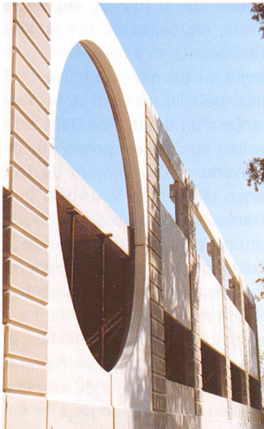
Fig. 8 Détail façade (ouest, côté parc)
