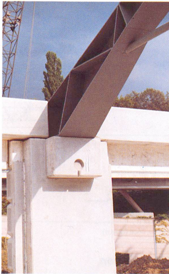
Fig. 7 Appui de la charpente métallique du toit
