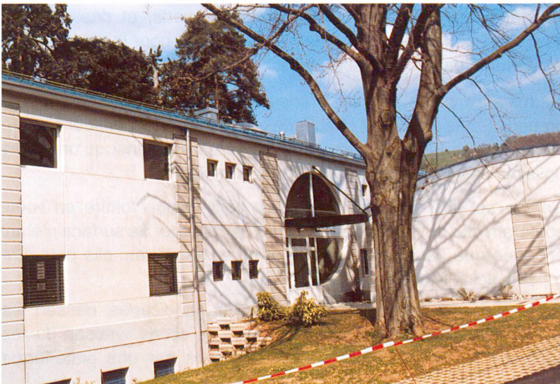
Fig. 1 Entrée clients (est, côté autoroute)
