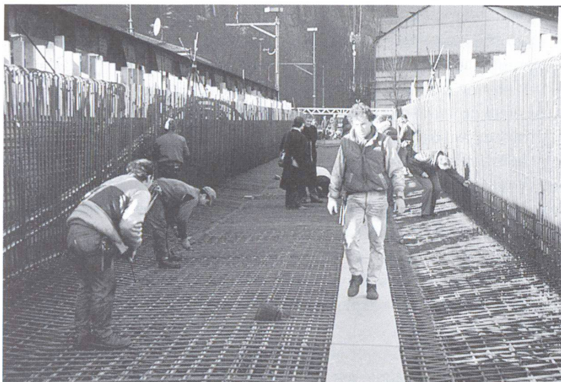
Pose de l'armature revêtue pour le tablier inférieur du pont CFF à Bodio.
