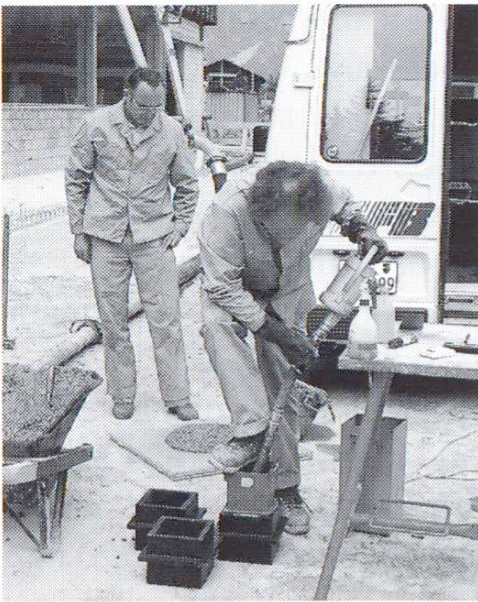
Compactage du béton au moyen d'un vibreur.
