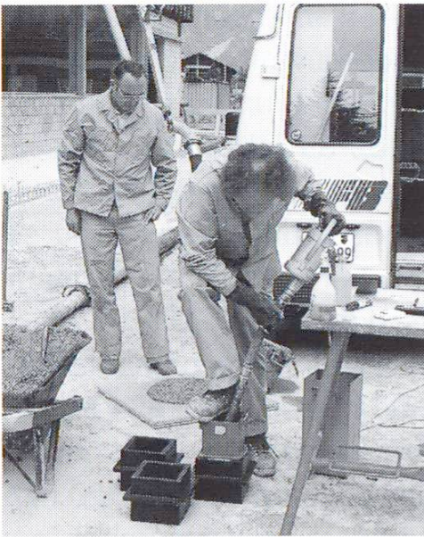
Compactage du béton au moyen d'un vibreur.
